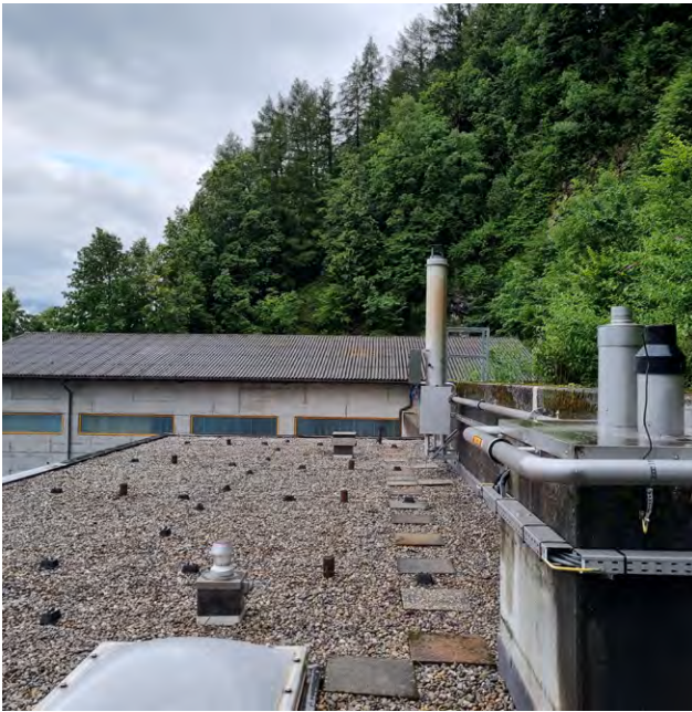
Abbildung 1: Flachdach über Betriebsräumen
