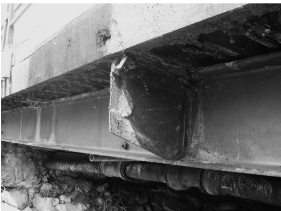
Abbildung 1 Untersicht best. Brücke
