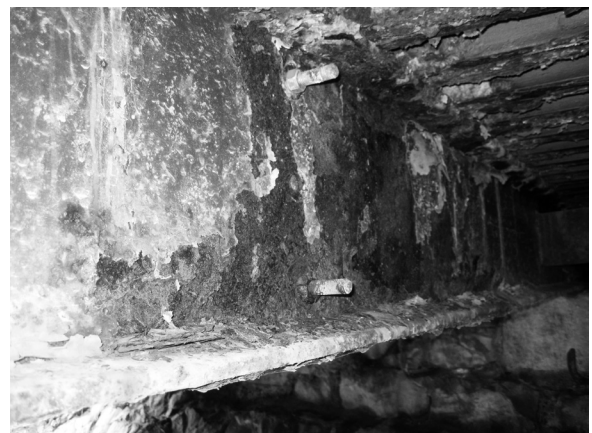
Abbildung 2 Schadensbild Längsträger
