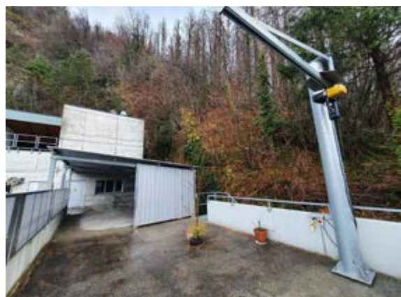
Hebekran – Überdachung Treppe/Materialraum
