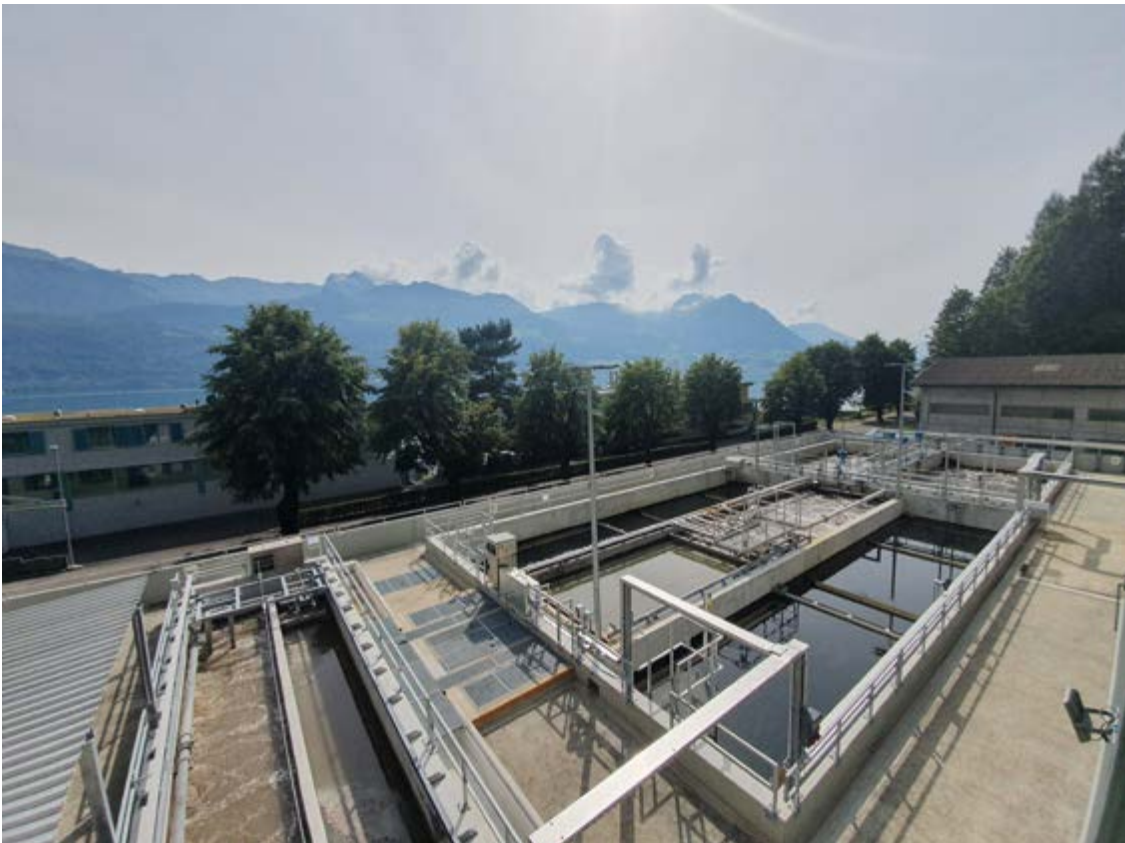
Gesamtansicht der erneuerten ARA Aussenanlage
